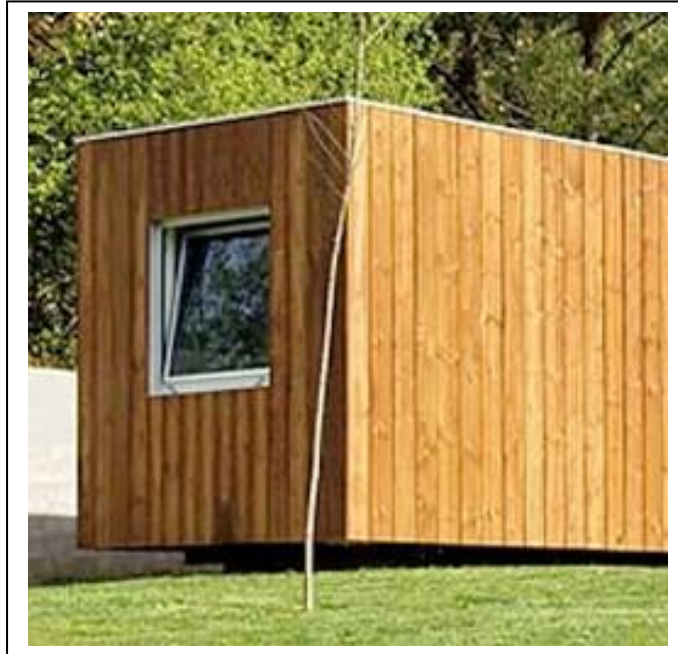
Gambar 5.12 Penutup dinding pane kayu
