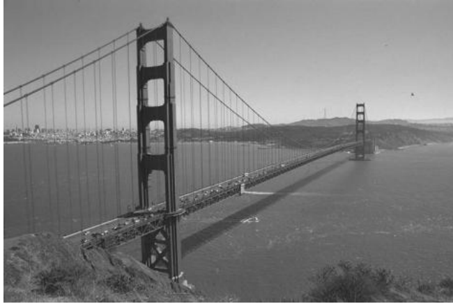
Gambar 2. 26 Struktur Kabel
