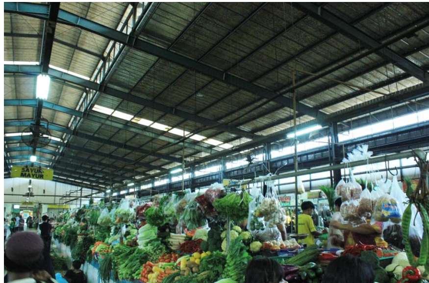
Gambar 3. 5 Struktur atap bangunan pasar
