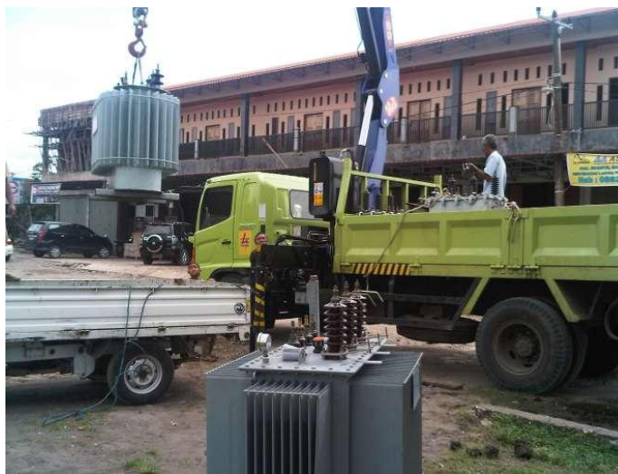
Gambar 3.9 Penaikan/Penurunan Transformator menggunakan mobile-crane
