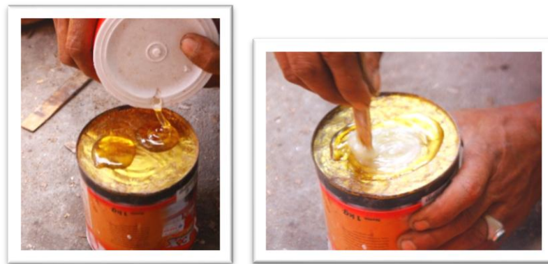
Gambar 3.59 Proses Menyiapkan Lem Sumber : Dokumentasi Pribadi
