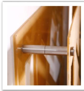
Gambar 3.90 Pen Iklan yang Sudah dipasang Sumber : Dokumentasi Pribadi
