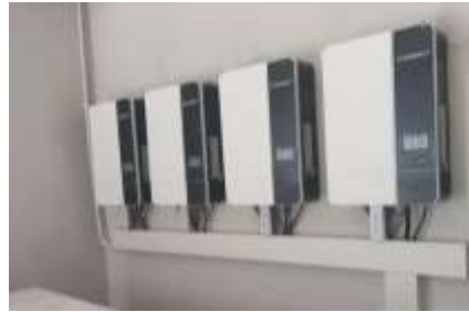
Gambar 3. 6 Konfigurasi MPPT (Dokumentasi pribadi)
