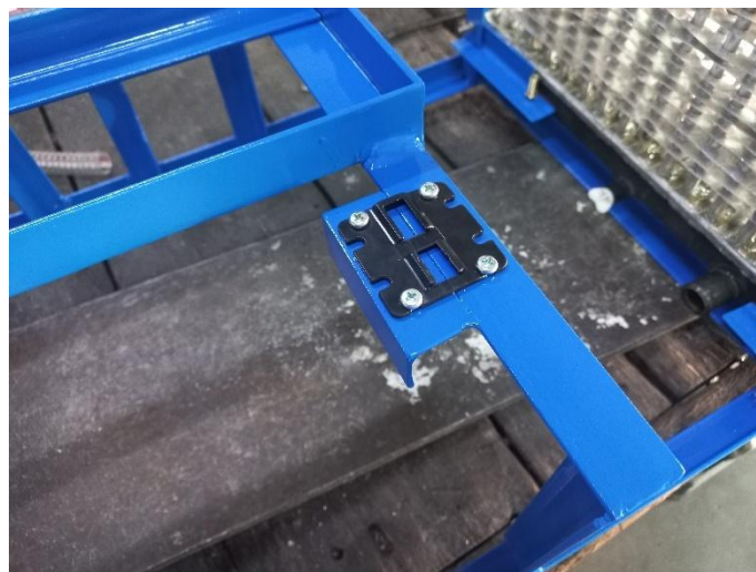
Gambar 4. 11 Pemasangan Bracket Pompa Air
