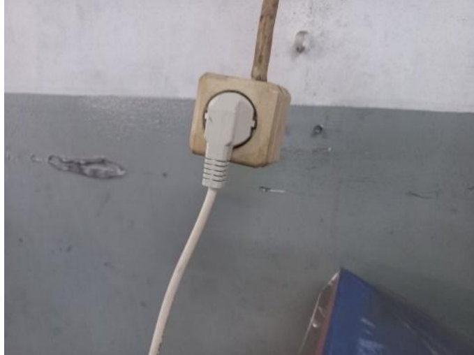
Gambar 4. 24 Memasangkan Terminal pada Stopkontak
