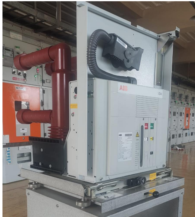
Gambar 3. 8 PMT 20 kV Three Pole GIS Gedebage
