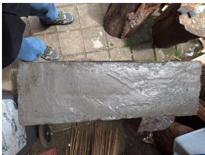
Gambar 3. 31 studi teknik plester dengan menggunakan campuran pasir dan semen (Sumber: Dokumentasi Penulis, 2025).
