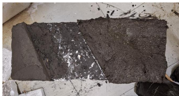
Gambar 3. 32 Studi teknik plester dengan menggunakan campuran pasir dan semen (Sumber: Dokumentasi Penulis, 2025).
