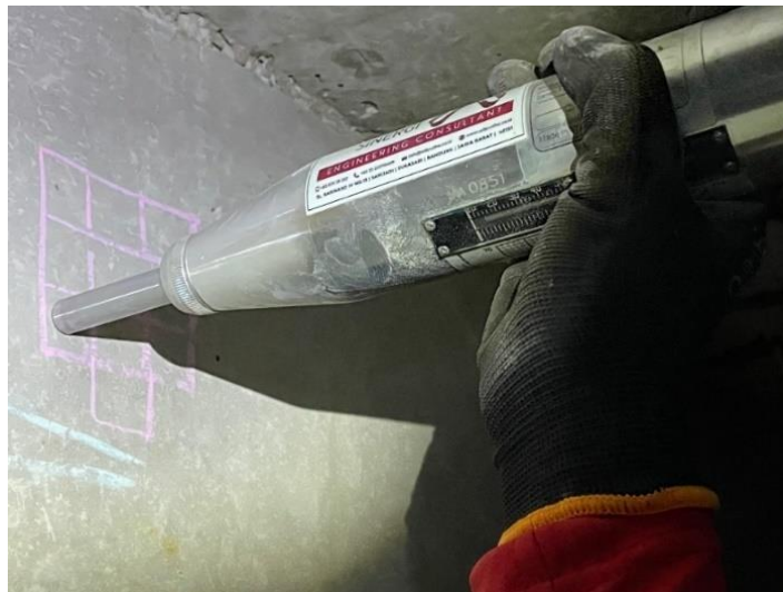
Gambar 3. 4 Contoh Pengujian Rebound Hammer
