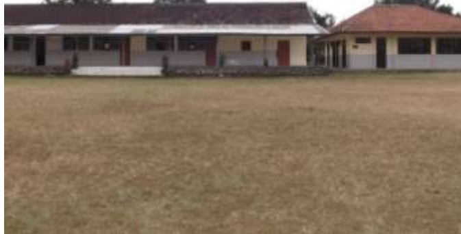
Foto 3.1 Gedung Kesenian SLBN A Pajajaran Bandung (Dokumentasi Puri, September 2014)
