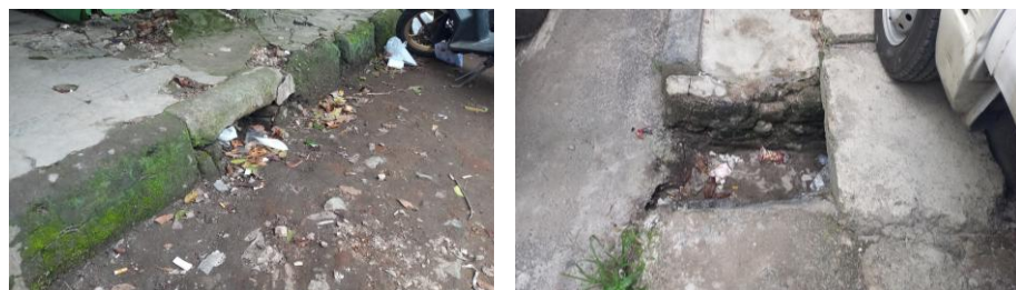
Gambar 3.9. Lubang Pembuangan Limpasan Air dari Jalan Sumber: Sumber pribadi (2024)
