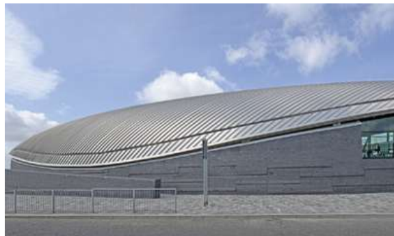
Gambar 3. 21 Contoh penerapan atap Kalzip pada permukaan melengkung
