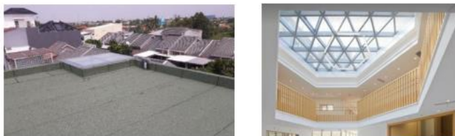
Gambar 3.15 Atap dak beton dan skylight
