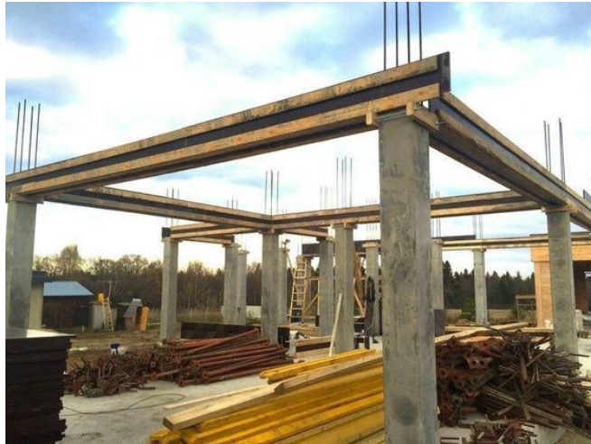
Gambar III.21 Struktur Rangka Beton
