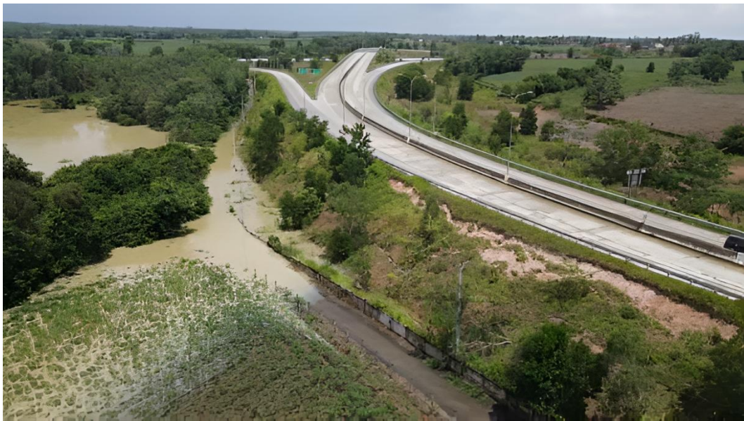
Gambar 1.3 Longsor Ruas Jalan Tol Terpeka Akses Gunung Batin
