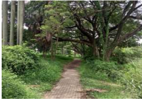
Gambar 1.2 Kondisi Jalur Lari yang Rusak
