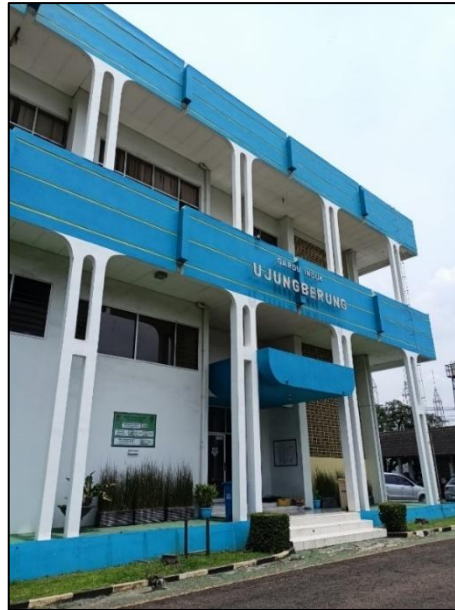
Gambar 3. 2 Gardu Induk Ujungberung 150 kV
