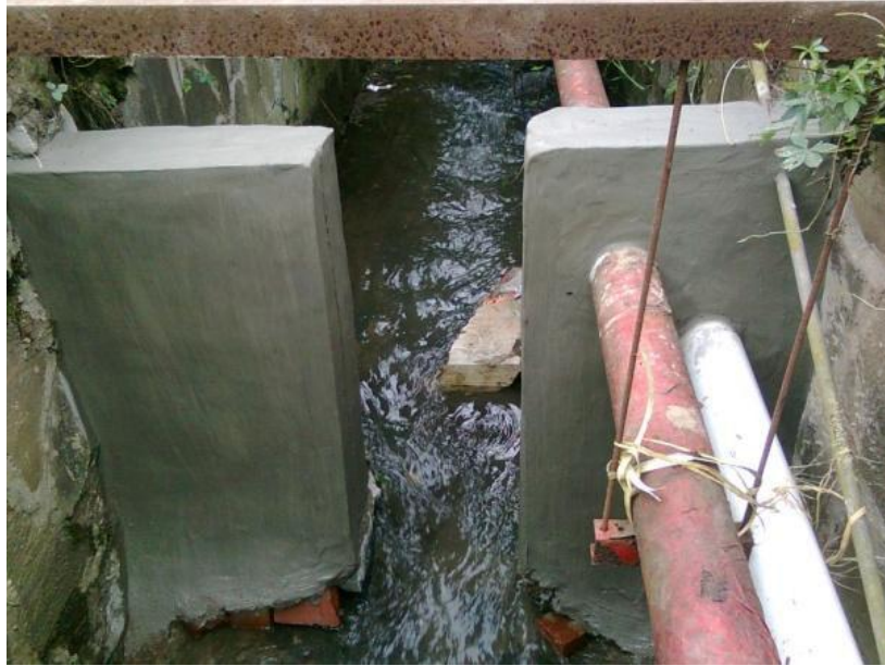
Gambar 3.5 Bendungan Pada Saluran Air Sungai
