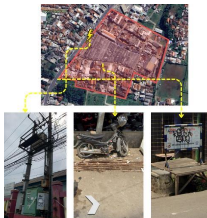
Gambar 3.13 Gardu Listrik dan Selokan Area Pasar
