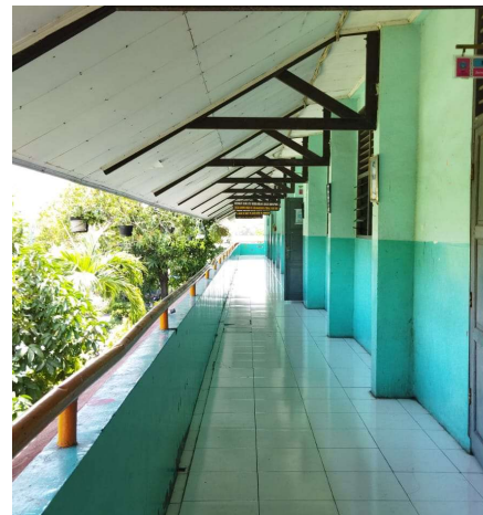
Dokumentasi 8 Koridor Sekolah Lantai 2
