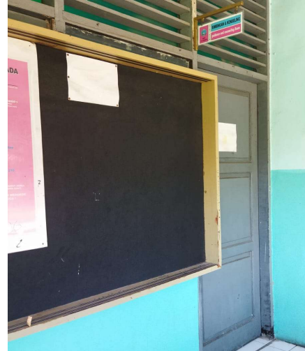
Dokumentasi 7 Ruang BK
