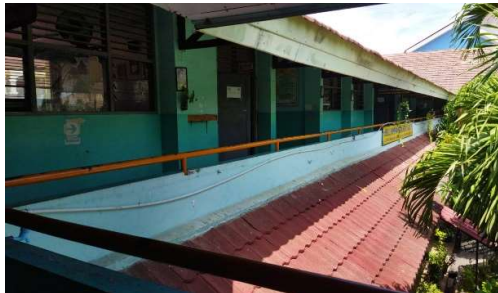
Dokumentasi 5 Lantai 2 Sekolah
