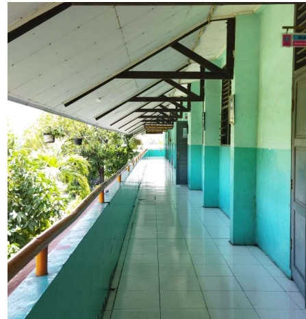
Dokumentasi 8 Koridor Sekolah Lantai 2
