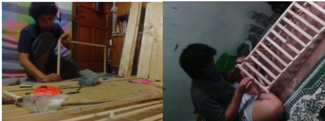
Gambar 3.52 Proses Membuat Konstruksi Atap (Dokumentasi Penulis)
