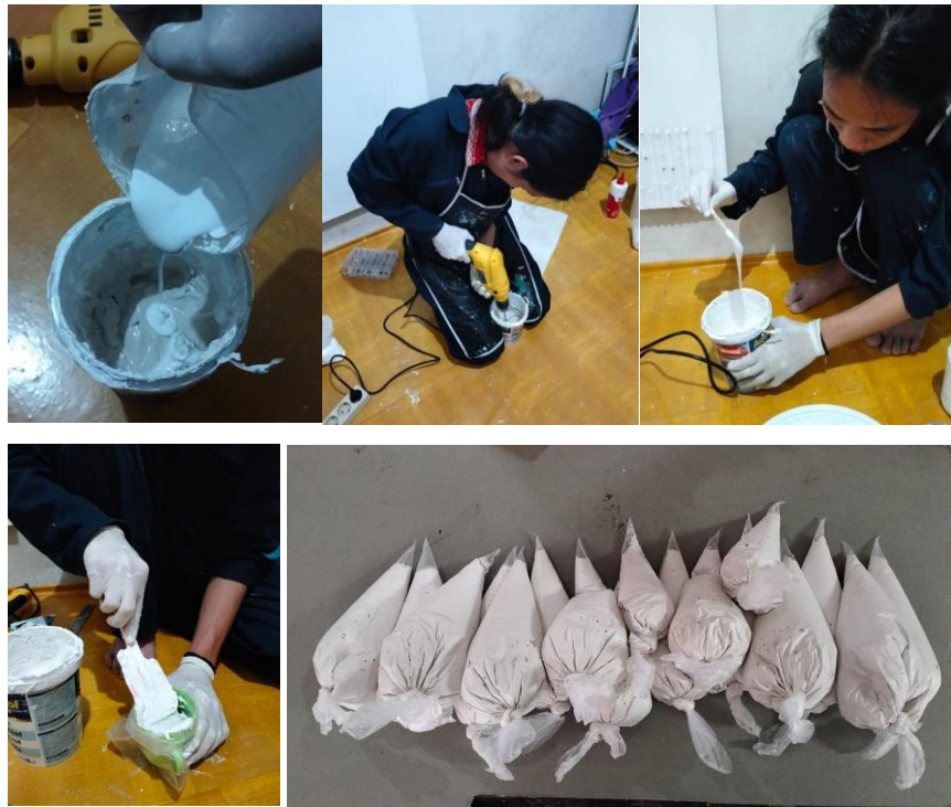
Gambar 3.84 Pengolahan Bahan (Sumber: Dokumentasi Penulis, 2022)
