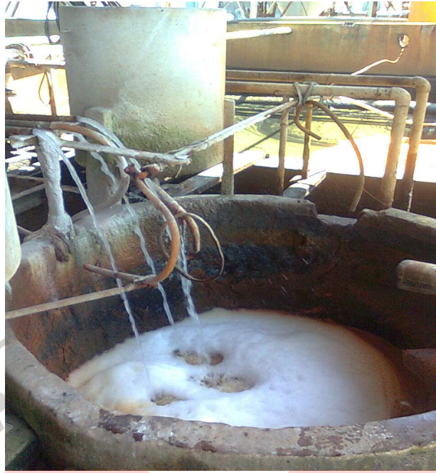
Gambar 3.4 Pemberian Flokulan Pada Bak Pengaduk Cepat Sumber: Dokumentasi Pribadi
