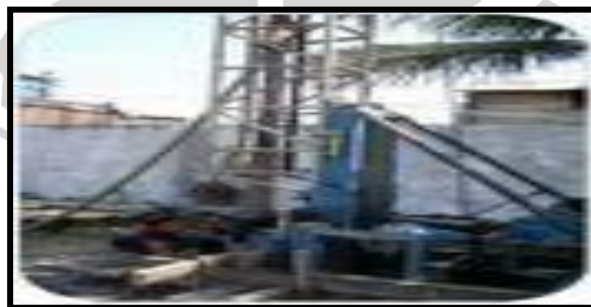
Gambar 2.8 Pembuatan Sumur Bor
