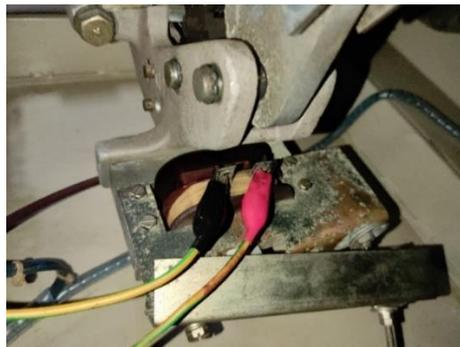
Gambar 3. 8 Coil pada *Generator Circuit Breaker Type 20-SFWA-80*
