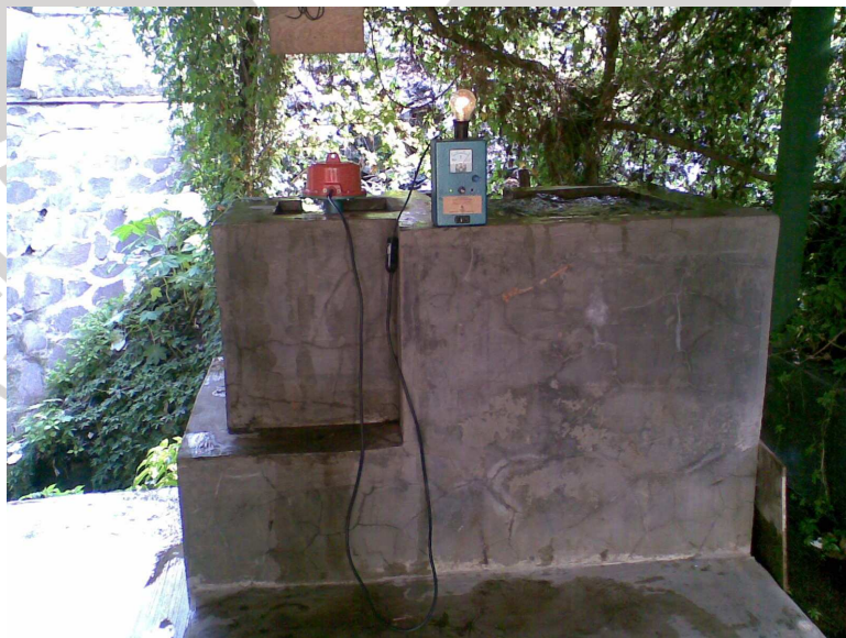
Gambar 3.6 Bak Penampung dan Bak Penempatan Turbin
