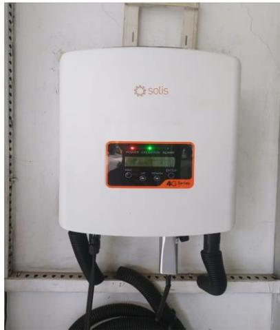
Gambar 3. 8 Inverter yang digunakan
