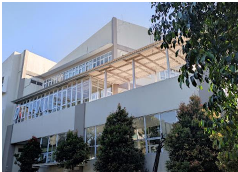
Gambar 3.1 Gedung Fisik SMP Tunas Unggul
